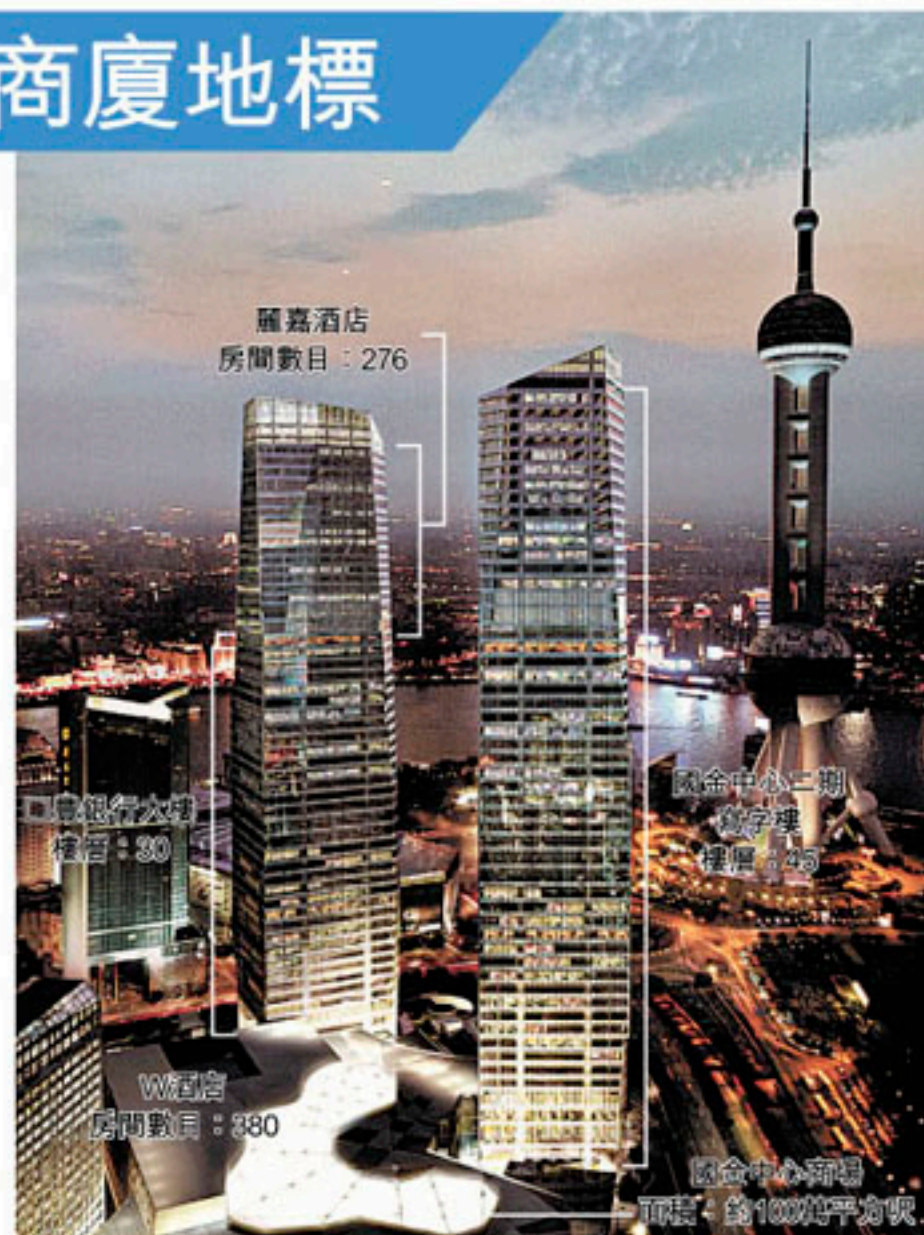
■上海國金中心（Shanghai ifc）是集合甲級寫字樓、大型商場及國際級酒店於一身的綜合項目。
