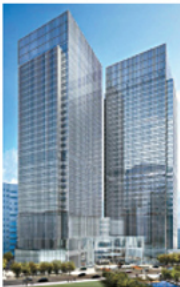
■葵涌地段215號正進行首期建築工程。
