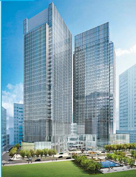
■葵涌市地段215號的優質寫字樓發展項目鄰近鐵路網絡，首期面積六十萬平方呎的工程進展順利，預期今年完成。
