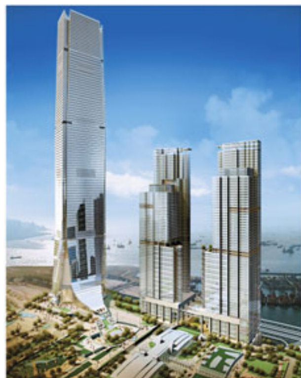
環球貿易廣場坐落於地鐵九龍站，第一期在2007年底經已落成。
